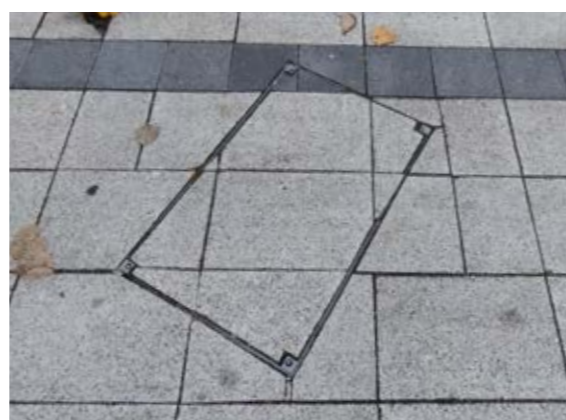
Сн. 149 Интегрирана настилка от бетонни плочи в капак на шахта под ъгъл. [Враца]
