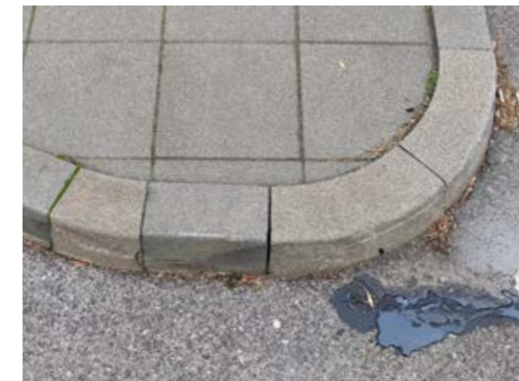
Сн. 228 Извити бетонни елементи при оформяне на пешеходен остров. [София, зона 2]
