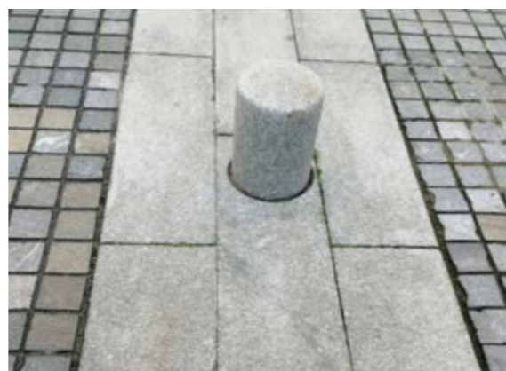
Сн. 163 Рязане и редене при елемент с кръгло сечение. [Дъблин, Ирландия]
