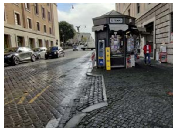
Сн. 243 Оформяне на рампа за автомобилен подход. [Рим, Италия]
