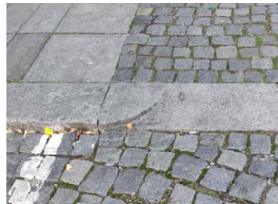
Сн. 224 Специален елемент за оформяне на понижаване при автомобилен преход. Подходящо при широки и ниски бордюри (до 10 см). [София, зона 1]
