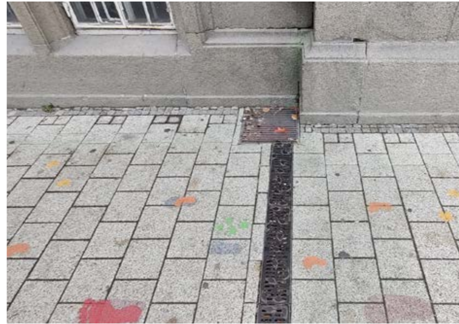
СН. 126 Пример за отвеждане на водите през улей с решетка в тротоара, бул. „Васил Левски“
