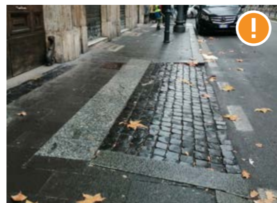
Сн. 242 Оформяне на рампа за автомобилен подход. Препоръчително е понижаването да се ограничи в зоната на бордюра при тесни тротоари. [Рим, Италия]
