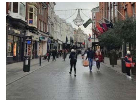
Сн. 216 Изравняване на нивото на пътното платно при споделени улици. [Дъблин, Ирландия]
