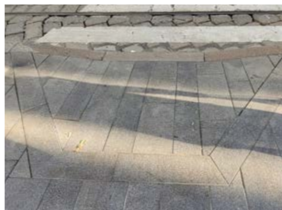
Сн. 211 Понижаване на тротоара при пешеходно преминаване. [Милано, Италия]
