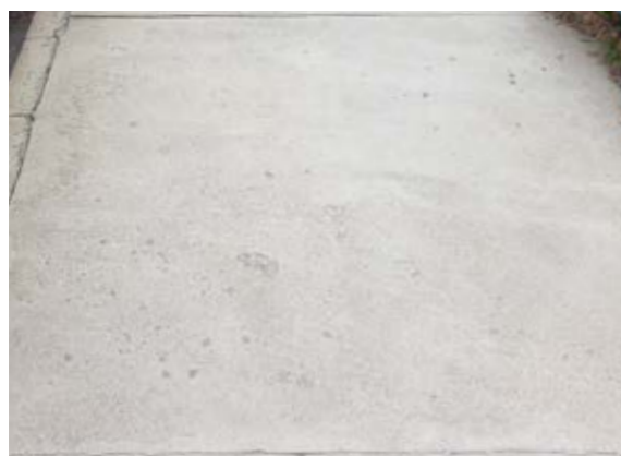
Сн. 025 Лят бетон [зона 6]
