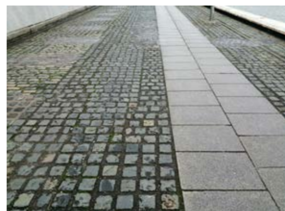
Сн. 189 Интегрирана проходима ивица от каменни плочи. Смяна на настилката без разделителна ивица. [Дъблин, Ирландия]
