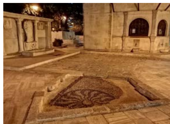
Сн. 187 Запазен участък от стара каменна настилка в контакт със съвременна каменна настилка. Смяна на настилката без разделителна ивица. [Ираклио, Крит]
