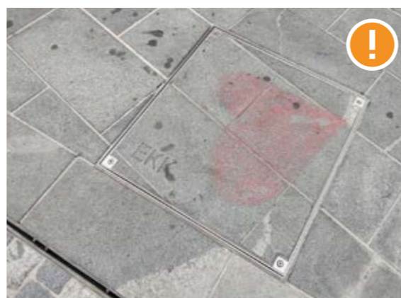
Сн. 147 Интегрирана настилка от каменни плочи в правоъгълен капак на шахта. При настилка, която се лепи за основата и за капак на шахтата, се допуска употребата на малки парчета. [Виена, Австрия]
