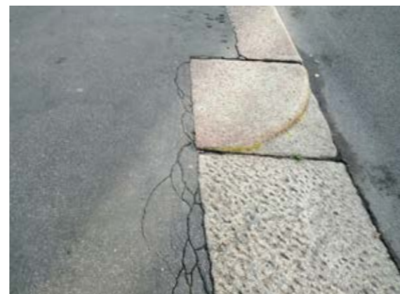
Сн. 225 Специален елемент за оформяне на понижаване при автомобилен преход. [Милано, Италия]
