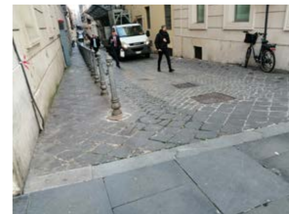
Сн. 176 Бордюр, който служи за разделителна ивица между различни каменни настилки. [Рим, Италия]
