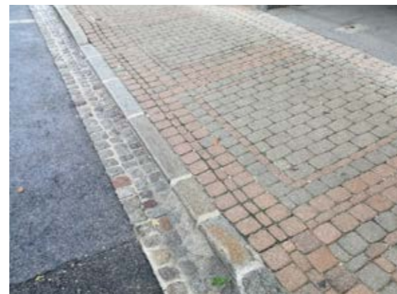
Сн. 240 Оформяне на рампа за автомобилен подход. [Клагенфурт, Австрия]
