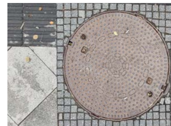
Сн. 153 Рязане и редене при кръгъл капак на шахта. [София, зона 2]
