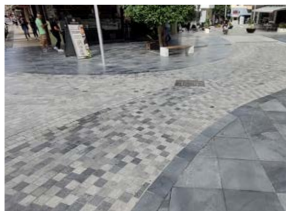
Сн. 136 Регене и рязане на настилката при крива. [Хераклион, Гърция]
