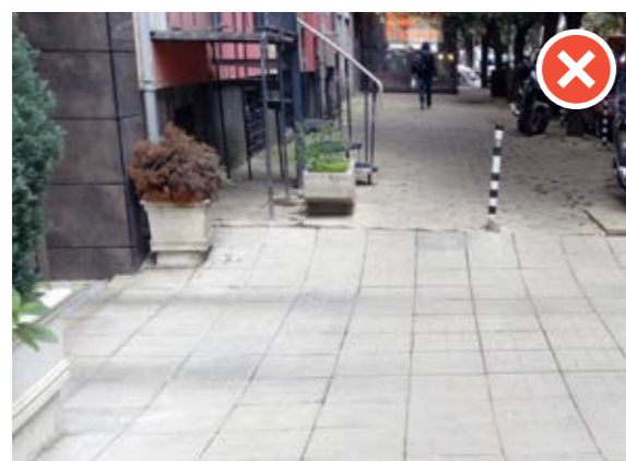
Сн. 239 Понижаване на настилката, което създава неудобни наклони. [София, зона 2]
