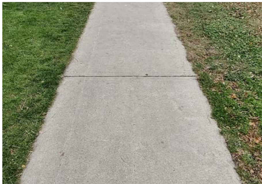
СН. 092 Тротоар с бетонна настилка, ул. „Козяк“
