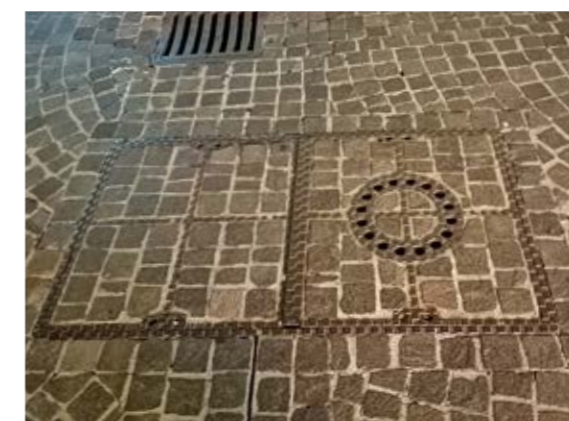
Сн. 151 Интегрирана настилка от каменни павега в правоъгълен капак на шахта. [Клагенфурт, Австрия]
