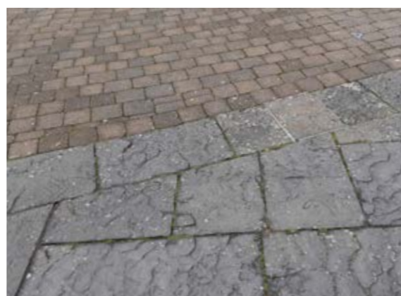
Сн. 173 Разделителна ивица между настилки от различен материал на начин на редене. [Дъблин, Ирландия]
