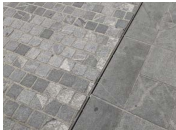
Сн. 184 Шлицово отводняване, което служи за раздели- телна линия. [Целе, Словения]
