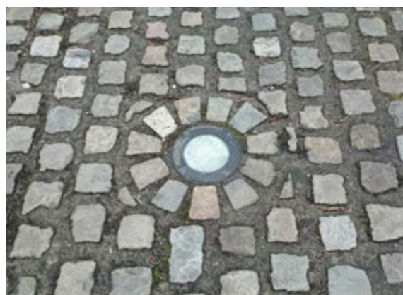
Сн. 159 Рязане и редене при елемент с кръгло сечение. [Дъблин, Ирландия]
