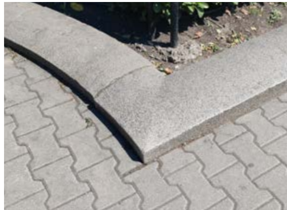
Сн. 219 Извити и ъглови каменни елементи при оформяне на зелена площ. [София, зона 2]
