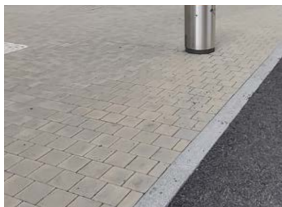
Сн. 181 Разделителна ивица между настилки с различна ос- нова. [Виена, Австрия]
