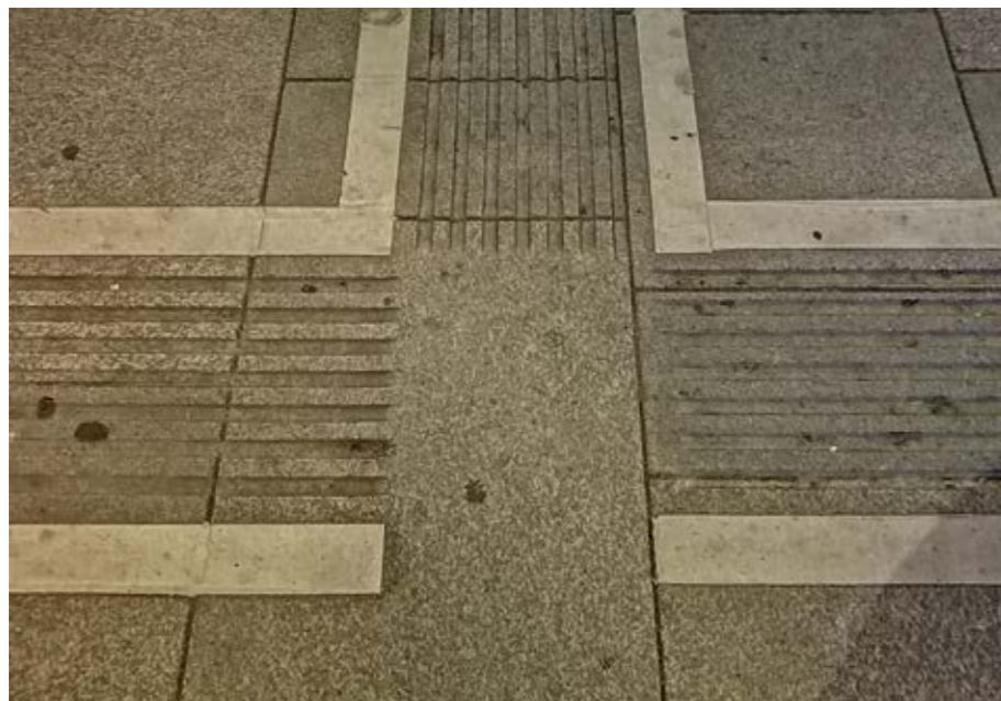
Сн. 106 Фрезована в настилката тактилна ивица, Виена, Австрия
