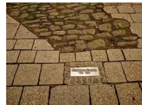
Сн. 195 Запазен участък от стара каменна настилка в контакт със съвременна каменна настилка. Смяна на настилката без разделителна ивица. [Виена, Австрия]
