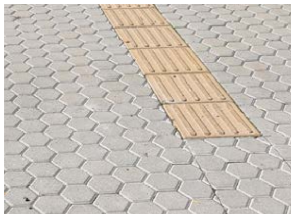
Сн. 012 Шестоъгълни бетонни павеа [зона 2]
