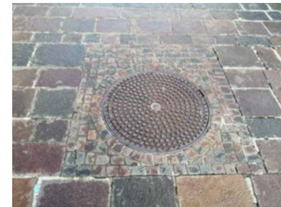
Сн. 152 Рязане и редене при кръгъл капак на шахта. [Клагенфурт, Австрия]
