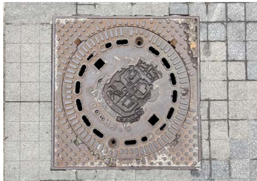
СН. 121 Кръгъл чугунен капак на шахта с квадратна рамка, ул. „Граф Игнатиев“
