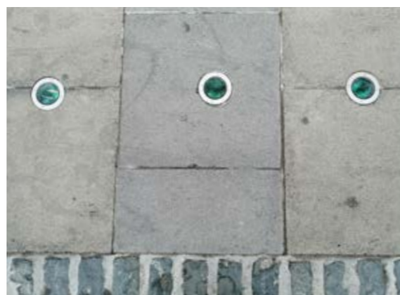
Сн. 162 Рязане и редене при елемент с кръгло сечение. [Дъблин, Ирландия]
