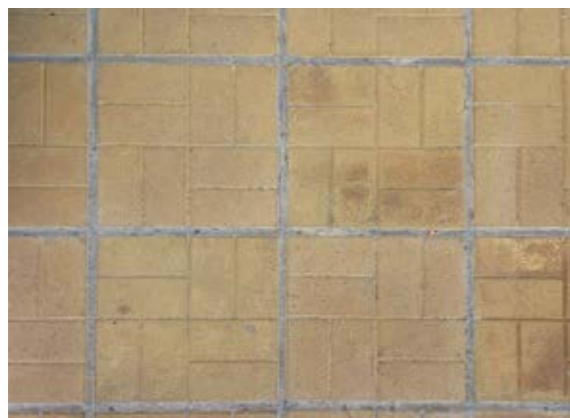
Сн. 024 Бетонни плочи [зона 6]
