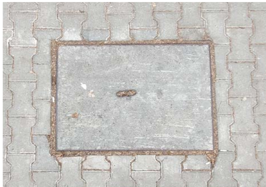
СН. 124 Правоъгълен капак на шахта с пълнеж от бетон, бул. „Цар Освободител“
