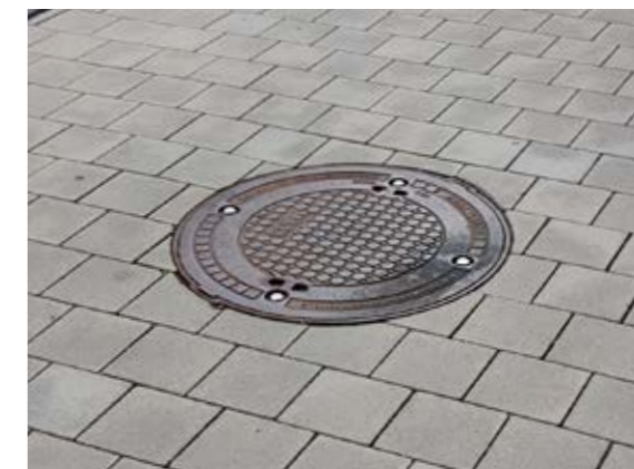
Сн. 154 Рязане и редене при кръгъл капак на шахта. [Виена, Австрия]
