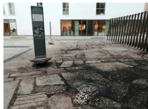
Сн. 191 Запазен участък от стара каменна настилка в контакт със съвременна каменна настилка. Смяна на настилката без разделителна ивица. [Милано, Италия]
