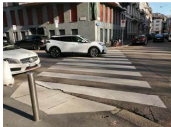
Сн. 212 Понижаване на тротоара при пешеходно преминаване. [Милано, Италия]
