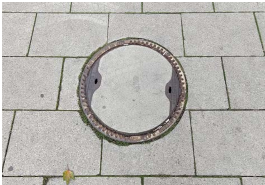
СН. 120 Чугунен капак на шахта с пълнеж от бетон, пл. „Атанас Буров“
