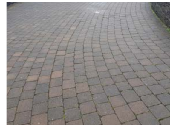
Сн. 141 Регене на настилката при крива. [Скалите на Мохер, Ирландия]
