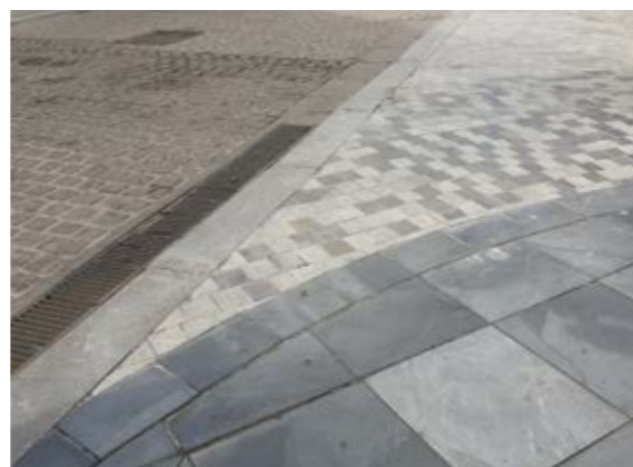
Сн. 174 Разделителна ивица между различни каменни настилки. [Хераклион, Гърция]
