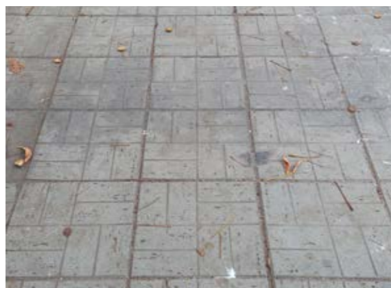
Сн. 023 Бетонни плочи [зона 5]
