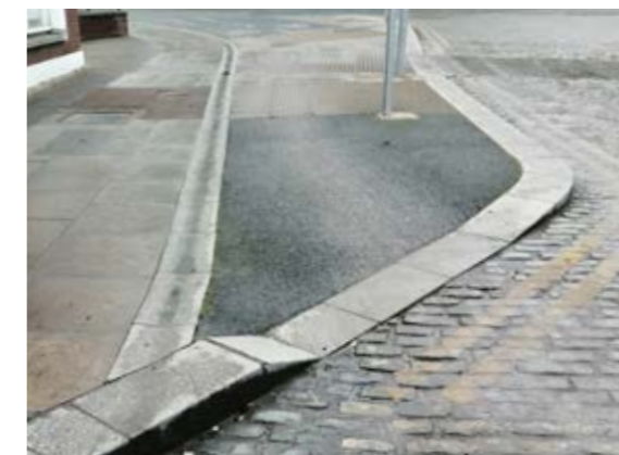
Сн. 229 Наклонени каменни елементи при понижаване. [Дъблин, Ирландия]
