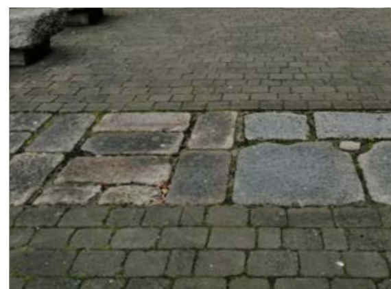
Сн. 192 Запазен участък от стара каменна настилка в контакт със съвременна каменна настилка. Смяна на настилката без разделителна ивица. [Дъблин, Ирландия]
