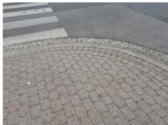
Сн. 213 Понижаване на тротоара в целия участък на завоя. [Клагенфурт, Австрия]
