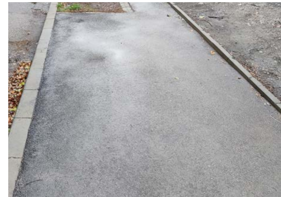
СН. 094 Тротоар с асфалтобетонна настилка, ул. „Три уши“
