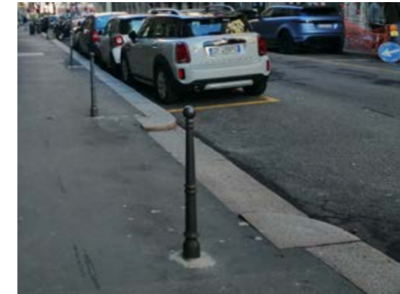
Сн. 245 Оформяне на рампа за автомобилен подход със специални елементи. [Милано, Италия]
