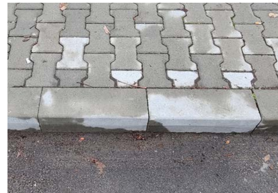
Сн. 110 Бетонни бордюри, ул. „Царибродска“
