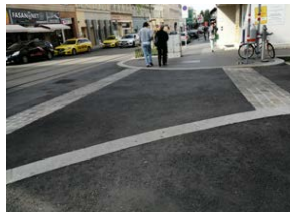
Сн. 208 Повдигната пешеходна пътека до нивото на тротоара. [Виена, Австрия]
