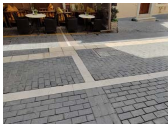
Сн. 172 Разделителна ивица между настилка с различна посока на редене. [Хераклион, Гърция]
