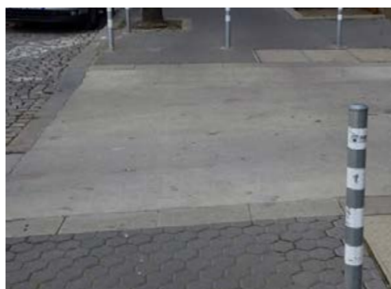
Сн. 182 Разделителна ивица между настилки с различна ос- нова. [София, зона 2]
