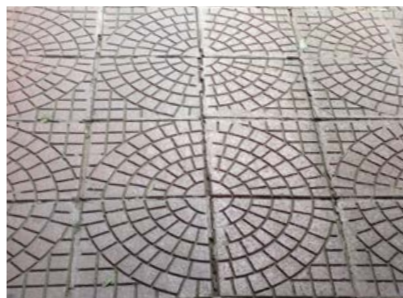
Сн. 015 Бетонни плочи [зона 2]
