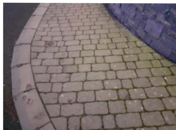
Сн. 139 Рязане и регене на настилката при крива. [Скалите на Мохер, Ирландия]
