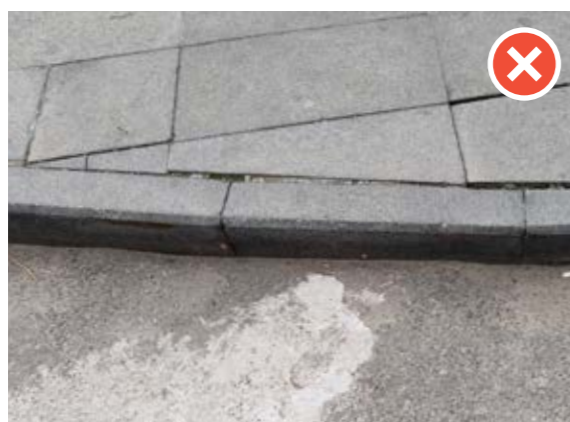
Сн. 137 Рязане и регене на настилката при крива. Да се избягва употребата на малки парчета, когато настилката не е залепена върху основата. [София, зона 1]
