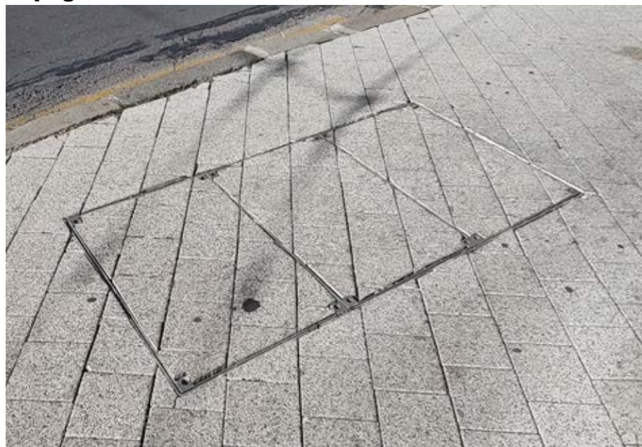
СН. 123 Капаци на шахти с вградена настилка, бул. „Васил Левски“
