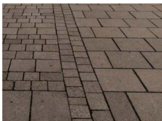
Сн. 169 Разделителна ивица от павега между настилки с различно редене. [Виена, Австрия]
