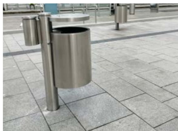
Сн. 161 Рязане и редене при елемент с кръгло сечение. [Дъблин, Ирландия]
