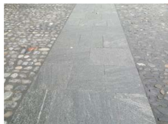
Сн. 190 Интегрирана проходима ивица от каменни плочи. Смяна на настилката без разделителна ивица. [Дъблин, Ирландия]
