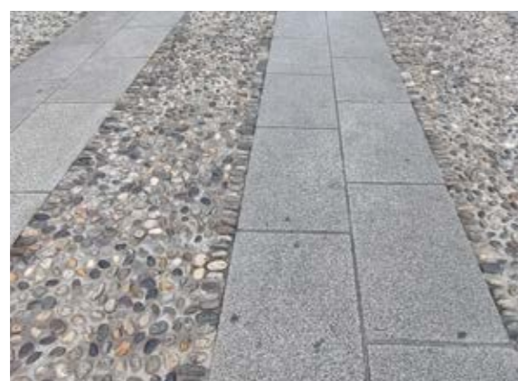
Сн. 186 Интегрирана проходима ивица от каменни плочи. Смяна на настилката без разделителна ивица. [Милано, Италия]
