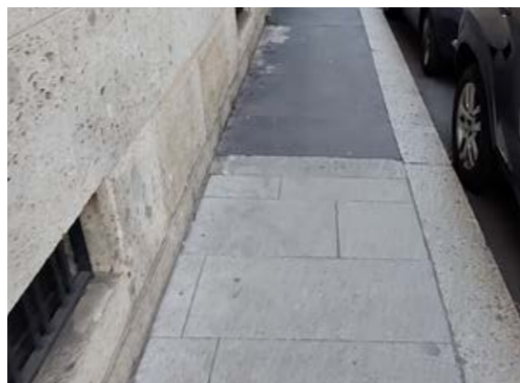
Сн. 180 Разделителна ивица между каменна настилка и асфал- тобетон. [Рим, Италия]
