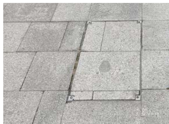
Сн. 144 Интегрирана настилка от каменни плочи в правоъгълен капак на шахта. [София, зона 2]
