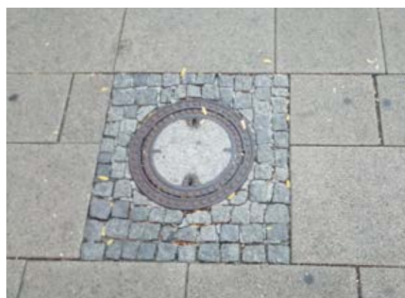
Сн. 158 Рязане и редене при елемент с кръгло сечение. [Виена, Австрия]
