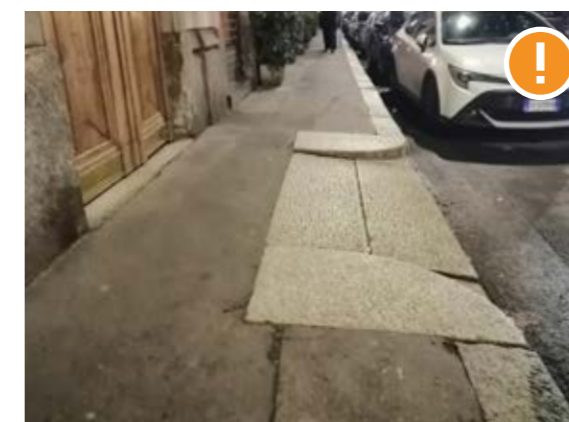
Сн. 247 Оформяне на рампа за автомобилен подход със специални елементи. Препоръчително е понижаването да се ограничи в зоната на бордюра при тесни тротоари. [Милано, Италия]
