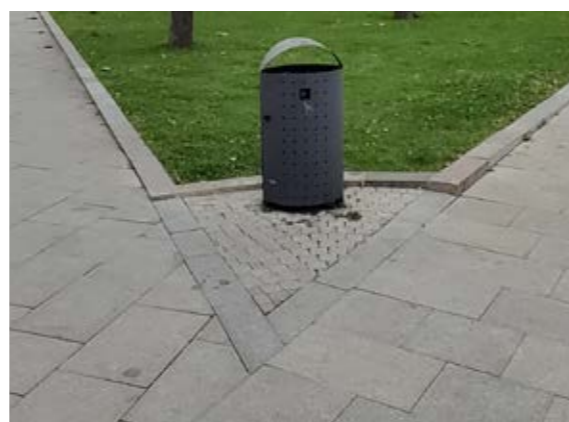
Сн. 175 Разделителна ивица от каменни елементи. [София, зона 1]
