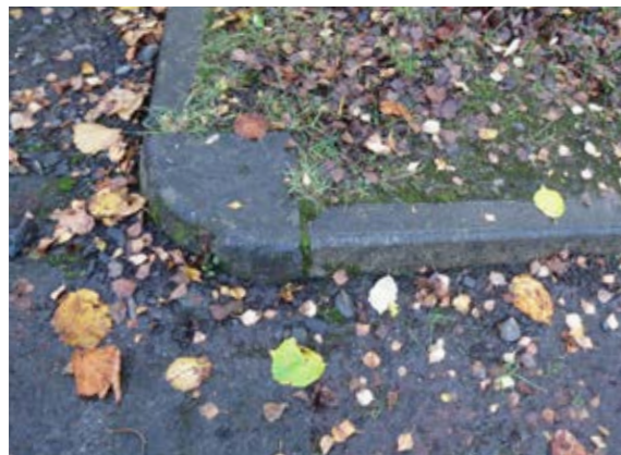
Сн. 220 Специален елемент за оформяне на ъгъл. [Нюгрейндж, Ирландия]
