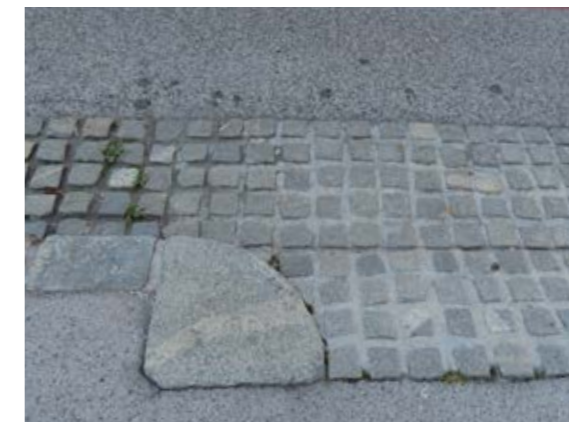
Сн. 226 Специален елемент за понижаване в зоната на бордюра при автомобилен подход. [Целе, Словения]
