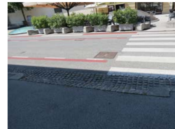
Сн. 244 Оформяне на рампа за автомобилен подход със специални елементи. [Целе, Словения]
