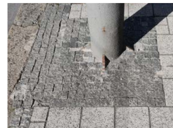
Сн. 166 Рязане и редене при елемент с кръгло сечение. [София, зона 1]
