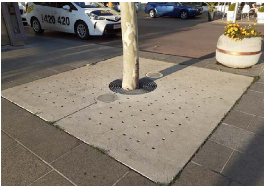
СН. 116 Оформяне на посадно място с бетонен елемент, Клагенфурт, Австрия
