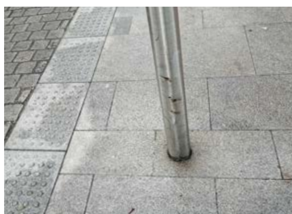
Сн. 160 Рязане и редене при елемент с кръгло сечение. [Дъблин, Ирландия]
