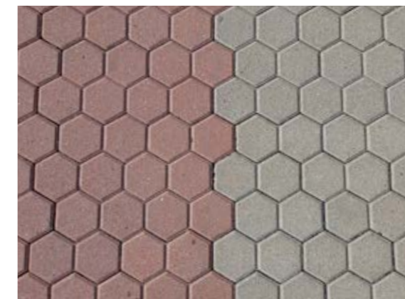
Сн. 021 Шестоъгълни бетонни павеа [зона 5]
