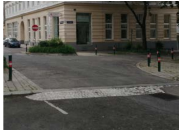
Сн. 237 Оформяне на рампа в зоната за автомобилно преминаване. [Виена, Австрия]
