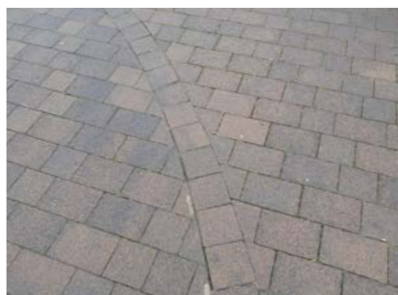
Сн. 140 Рязане и регене на настилката при крива. [Скалите на Мохер, Ирландия]
