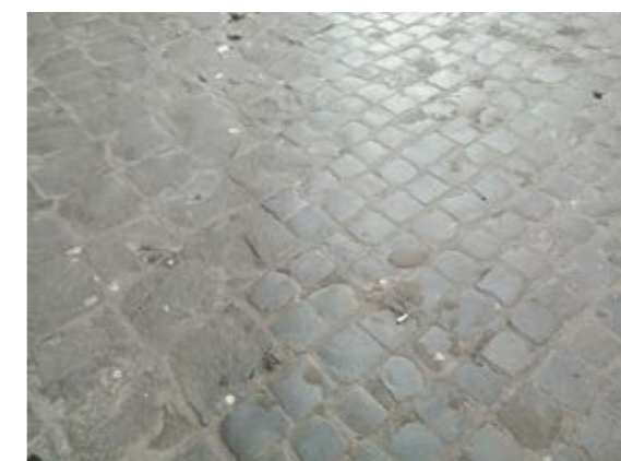
Сн. 196 Преход между каменни настилки без разделителна ивица. [Рим, Италия]
