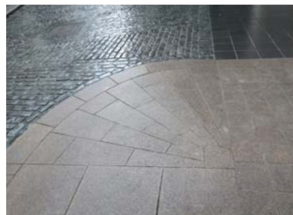
Сн. 210 Понижаване на тротоара при пешеходно преминаване. [Дъблин, Ирландия]
